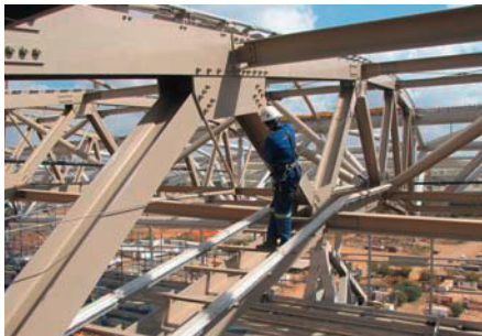
Utilisation type dans la construction (Stade Soccer City Sports – Afrique du Sud)
